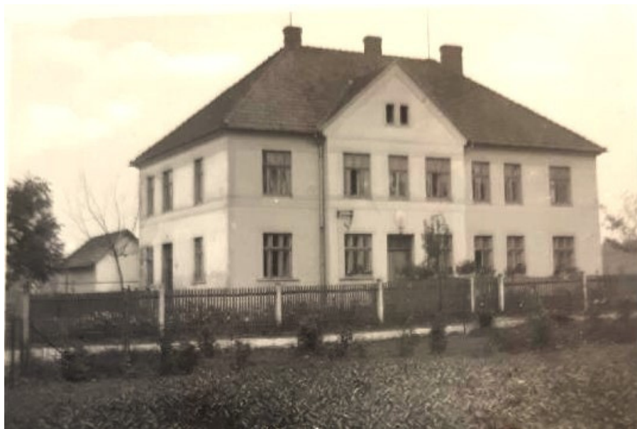
Pošta v obecním domě
