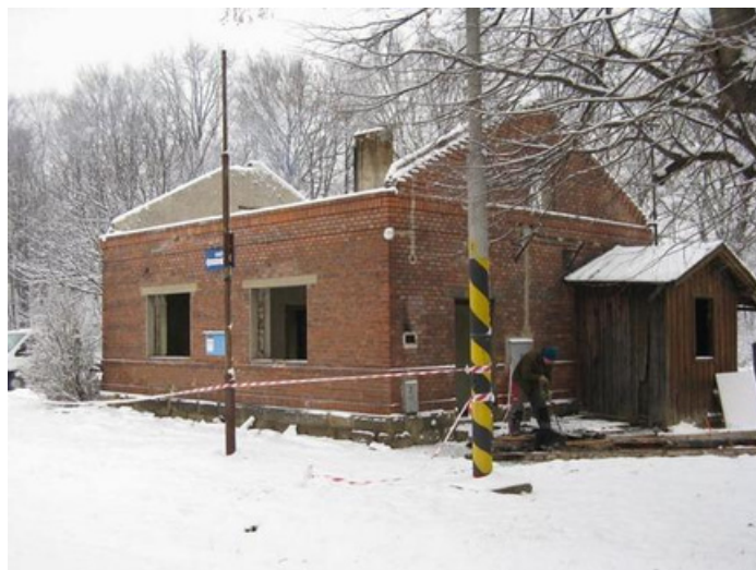
Bourání stanice v roce 2012
