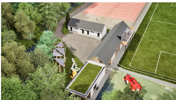
Východní pohled na areál
