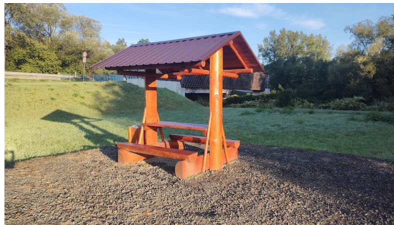
Oprava povrchu Cyklostezky Bečva a vybudování nových odpočinkových míst pro cyklisty
