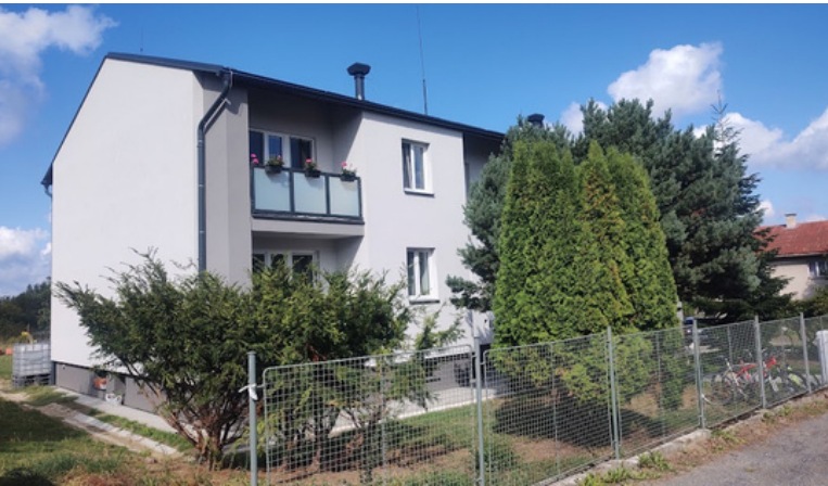
Revitalizace Bytového domu č.p. 242
