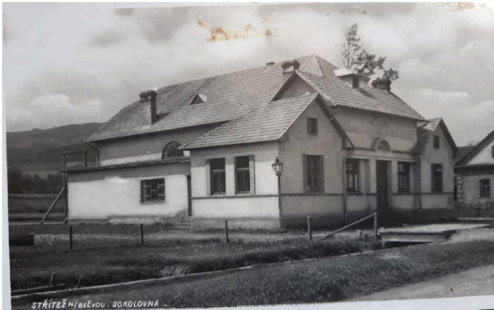
Budova sokolovny, foto kolem roku 1940
