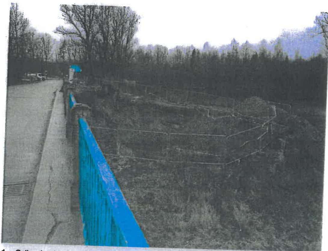
1. Celkový pohled na pravobřežní stavební jámu. Stav z listopadu 2020.
