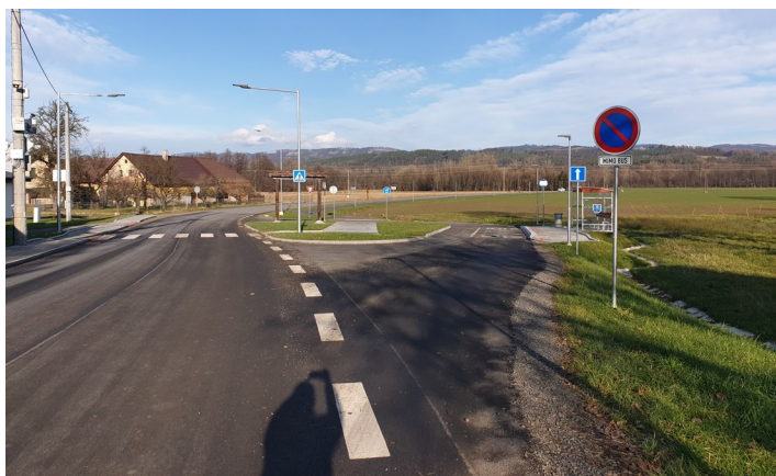
Nový železný most, který by měl být obložen ještě modřínovými latěmi, čeká na své osazení. Na fotografii je vidět, jak by mělo celé dílo vypadat po svém dokončení.
