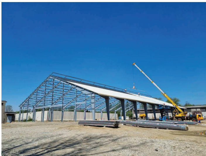
Na farmě Luhy probíhá výstavba nových stájí
